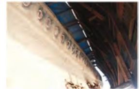
여주 이포리 가마의 화구. 사용할 때는 뚜껑을 열어 구멍에 나무를 넣어 온도를 조절한다. 평소에는 습도 조절을 위해 뚜껑으로 닫아 놓는다.
