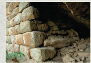
고구려 성산산성의 성돌이 서로 맞물린 모습 출처: 동북아역사넷.
